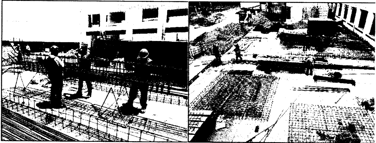
Foto N° 01 y 02: Vista de los Trabajos realizados en area de tanque elevado, preparacion del acero para losas y columnas.
