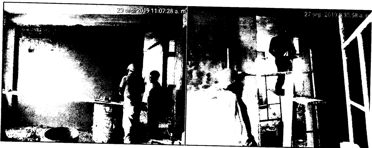
Foto N° 09 y 10: Vista de los Trabajos realizados en area de Administracion, construccion de tarrajeo interior.
